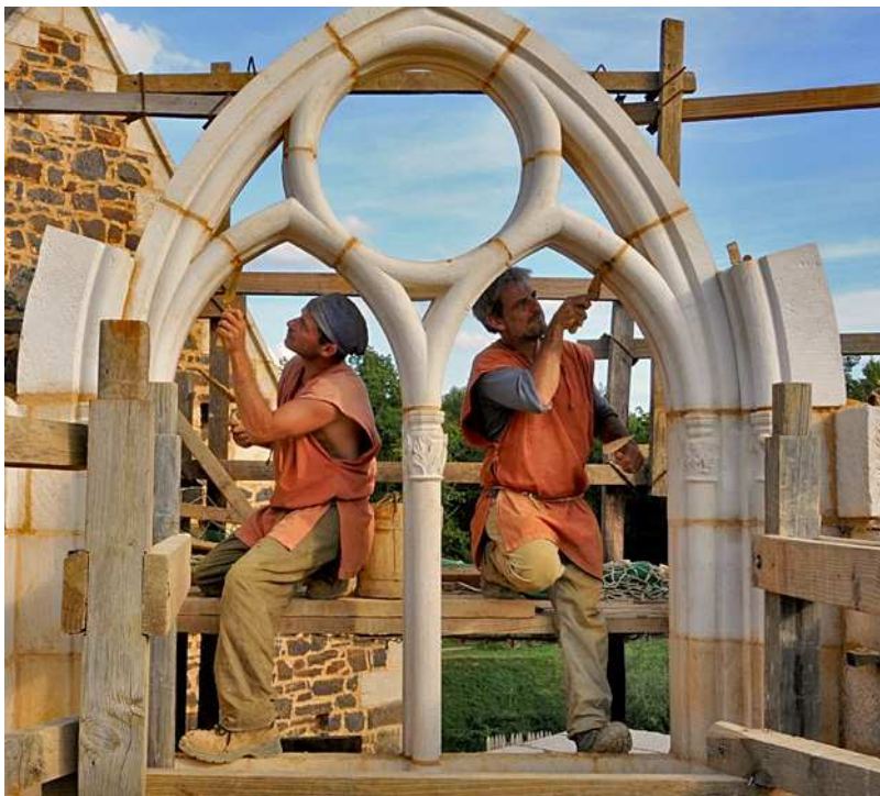
Aperçu du travail des ouvriers comme au 13 ème siècle.
